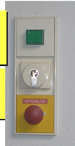
**Not-Aus-Einrichtungen müssen nach dem Abschalten gegen unbefugtes Wiedereinschalten gesichert sein (Schlüsselschalter)**
